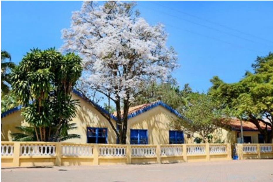
Figura 1 - Fachada do Museu Casa de Portinari
