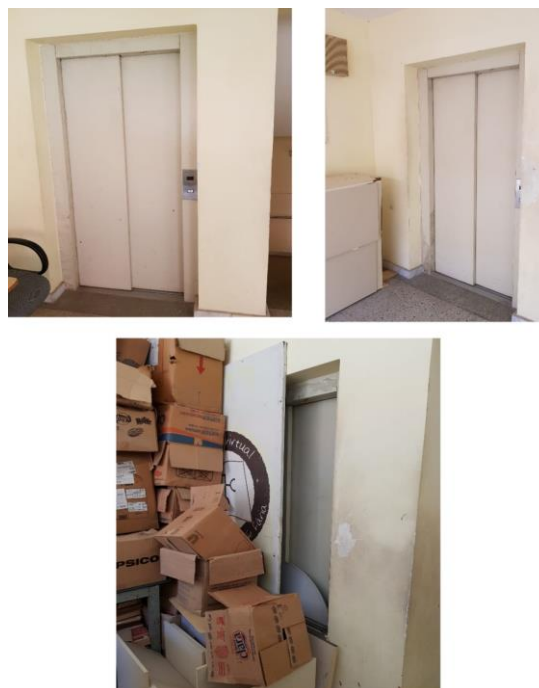
Figura 2: Local do elevador da Biblioteca Pública Municipal de Mossoró
